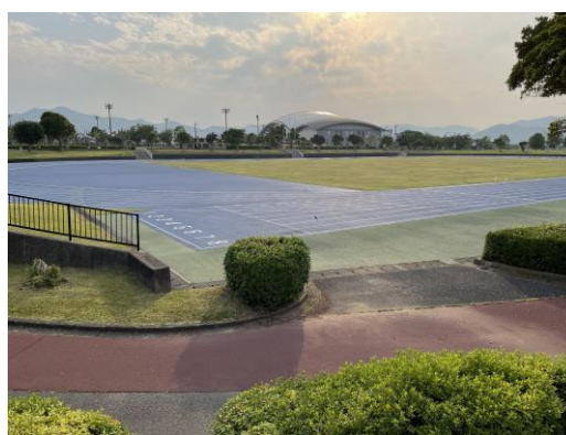
改修された全天候型陸上競技場
